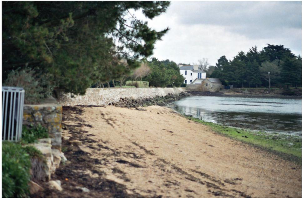
*Digue en maçonnerie avec enrochements au pied à Baden (Le Guern), protégeant une zone basse*
