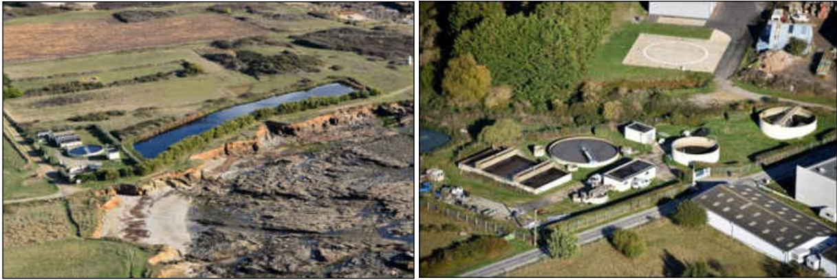
Figure 66 : Les stations d'épuration de Locmaria et du Gripp (Clichés : Géos/AEL)
