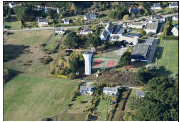
Figure 64 : Château d'eau de Créhal (Cliché : Géos/AEL)
