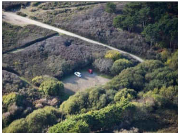
Figure 59 : La maîtrise de la fréquentation au niveau du Trou du Tonnerre - Création d'une aire de stationnement et pose de barrières (Cliché : Géos/AEL)
