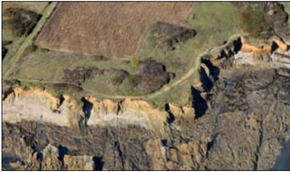
Figure 60 : La maîtrise de l'érosion côtière entre Locmaria et la Pointe des Chats, recul du sentier côtier (Crédit photo : Géos/AEL)
