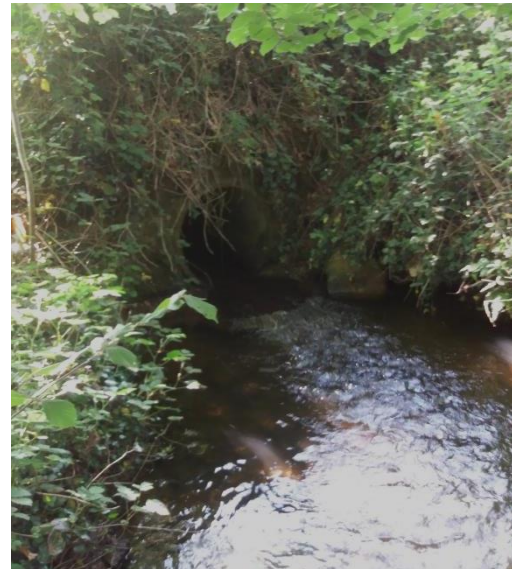
Photo 3 : OH3 (Ø 600) sous voie communale
