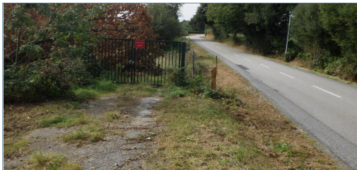
Photo 44 : route communale au nord de l'aire d'étude immédiate et chemin d'accès parallèle
