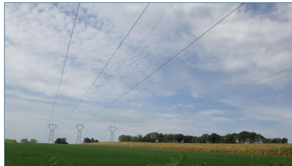
Photo 50 : lignes électriques traversant l'aire d'étude immédiate
