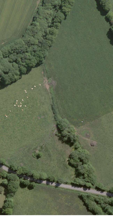
Photo 101.- Site de Kergrenouille avant le busage en juin 2013 (source : remonteletemps.ign.fr)
