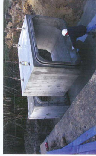
Photo 104 - Mise en place des modules préfabriqués
