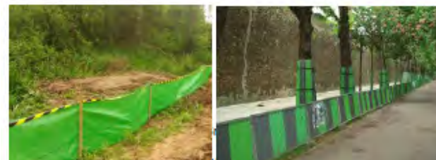
Illustration de mise en défens en phase chantier
