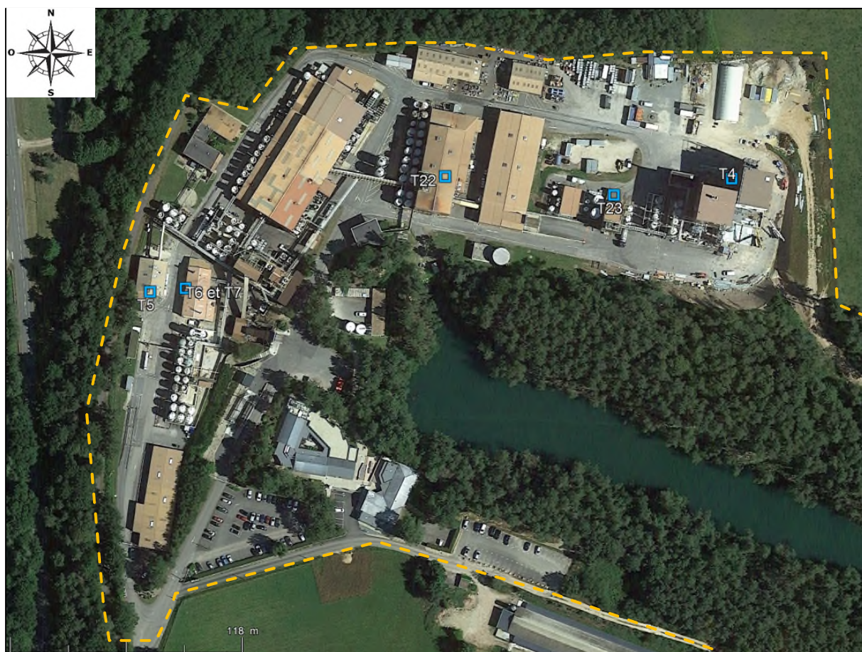
Figure 43. Localisation des transformateurs - Situation actuelle
