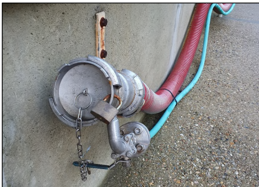
Figure 45. Exemple de verrouillage de raccord
