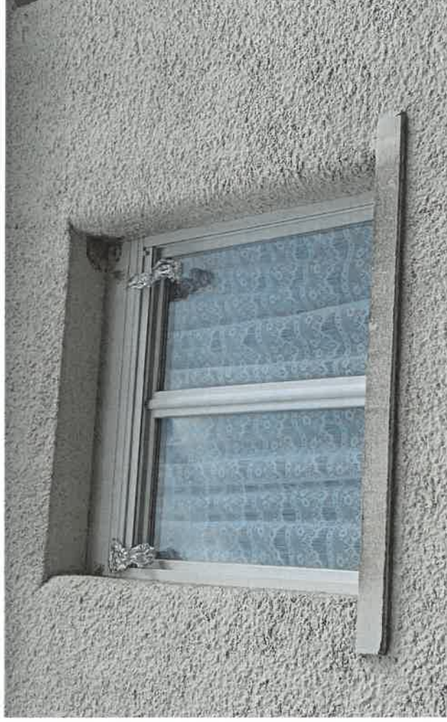
Dispositif anti-hironnelles sur au moins 6 fenêtres au niveau de la place principale de Trédion
