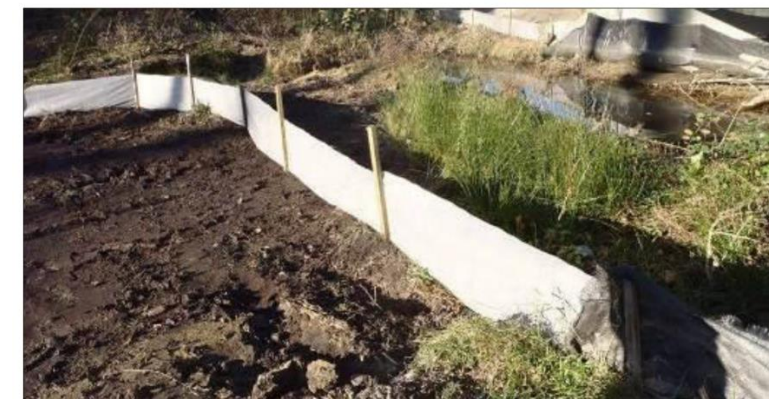
Figure 7: Exemple de barrière amphibiens en géotextile permettant d'éviter les déplacements
