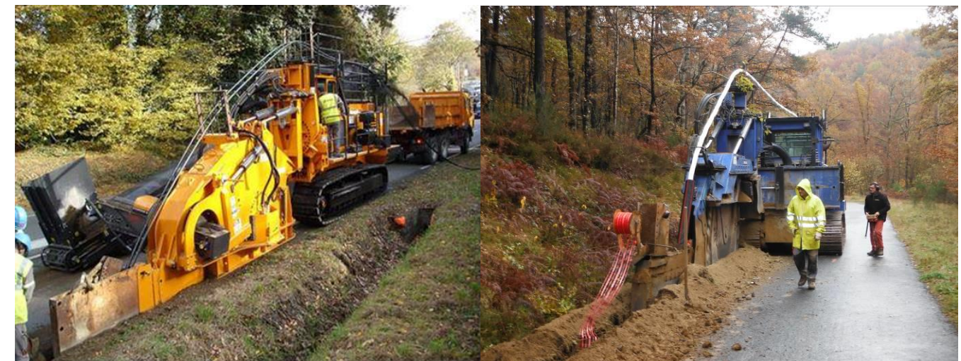
Figure 4: Trancheuse et exemple de pose de câble à la trancheuse
