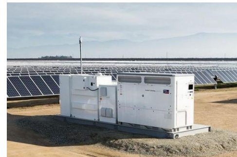
Figure 27 : Comparaison de différents onduleurs : strings (onduleur solaire, s.d.) ou centralisé (SMA, s.d.)
