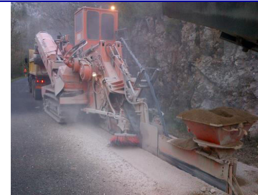
Figure 35 : Photo de trancheuse prise sur chantier
