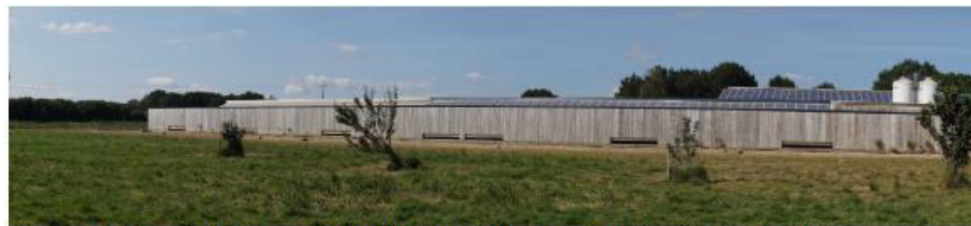
Photographie Z2 - Les bâtiments de l'exploitation avicole, vus depuis le périmètre de la ZIP
