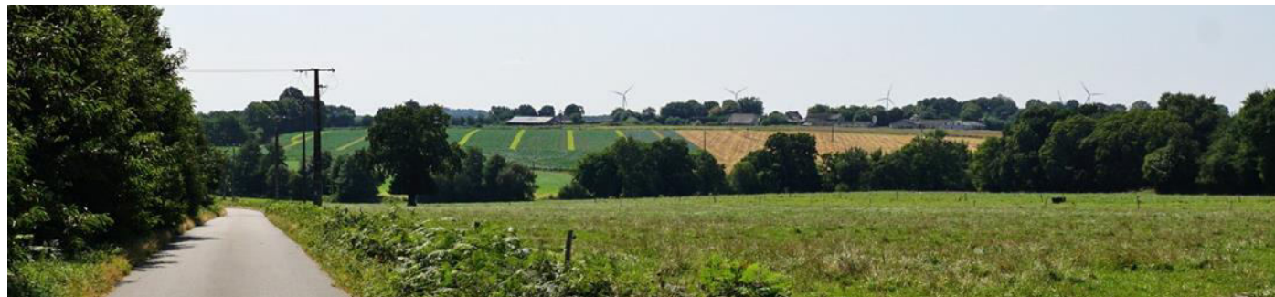
Figure 74 : L'entaille de la vallée du Léverin dans la moitié Sud de l'aire d'étude éloignée, vers le Ménéhy. Plus en arrière, on remarque le parc éolien de la Butte des Fraus (hors aire d'étude)
