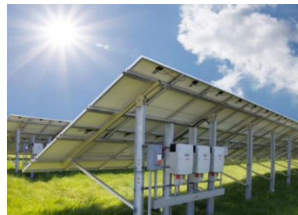
Figure 27 : Comparaison de différents onduleurs : strings (onduleur solaire, s.d.) ou centralisé (SMA, s.d.)
