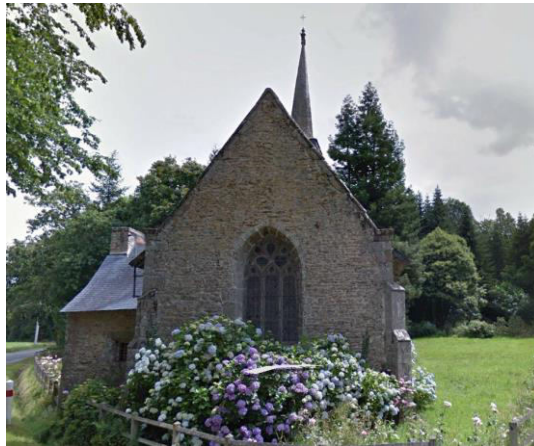
Figure 100 : Chapelle de Riaye (Source : Prise de vue Google earth)
