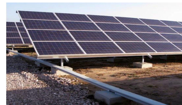
Figure 26 : exemple de pose de câble sur un chemin de câble DC ou souterrain AC/HTA (Comportement intempérie, s.d.) (Règles électricité entérées, s.d.)
