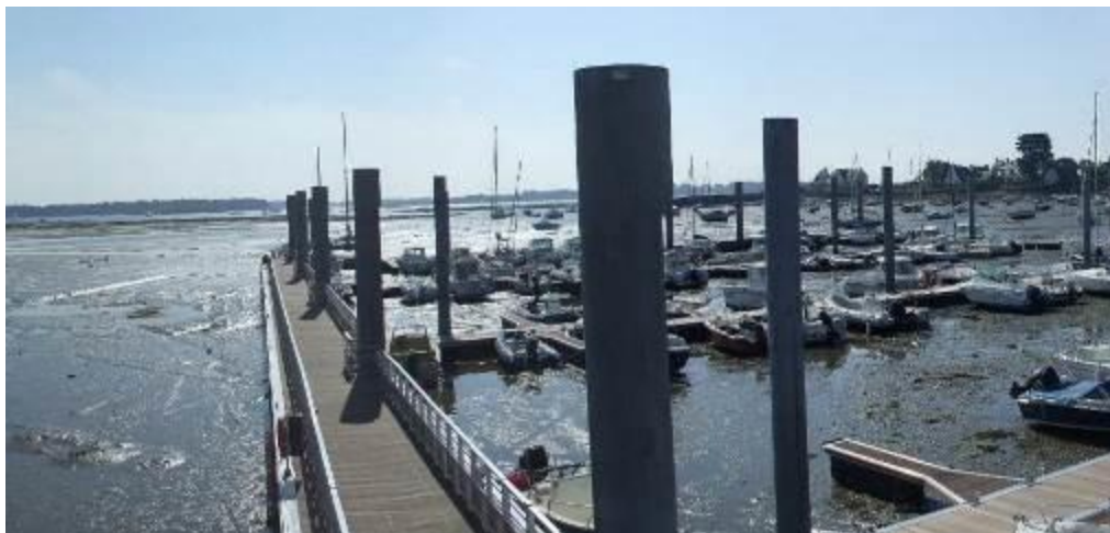
Figure 12 : Vue des infrastructures portuaires.
