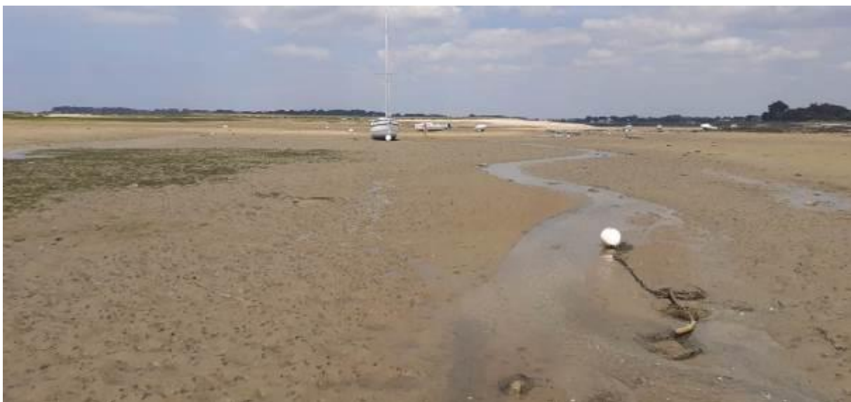
Figure 71 : Vues de la zone de mouillages de la Pointe Er Long dit encore « St Pierre » (en haut vue depuis la mer- en bas, vues depuis l'estran à marée basse).
