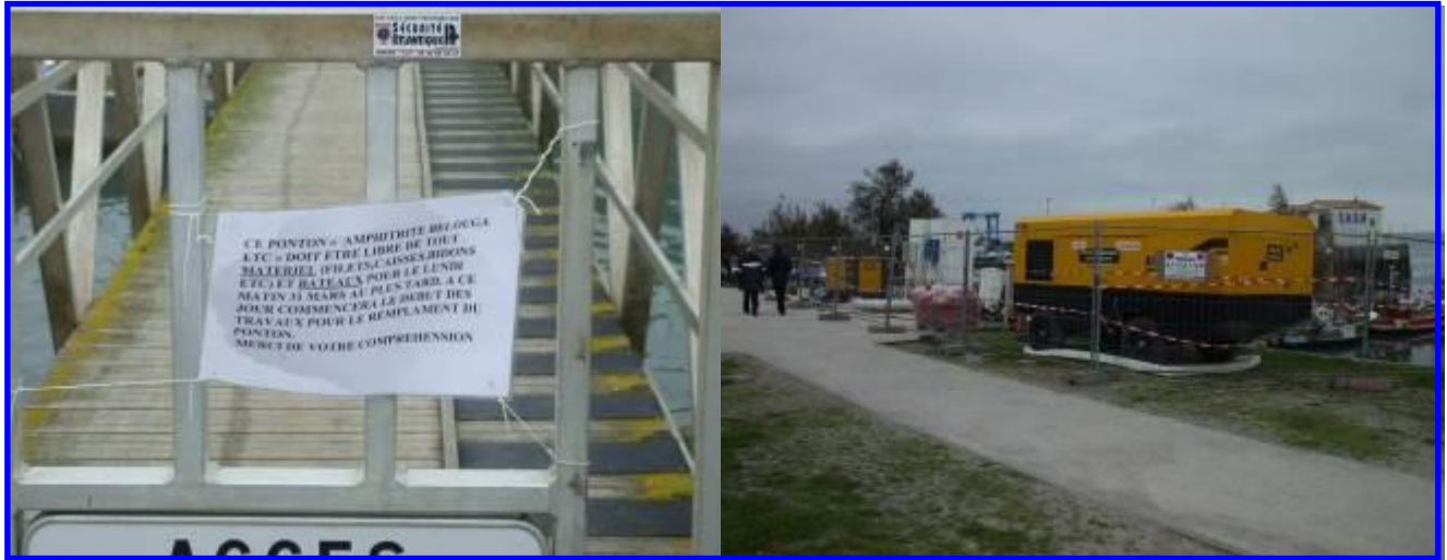
Figure 203 : Exemples d'information et de limitation de la zone relative au chantier.
