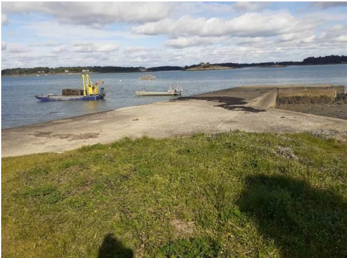
Figure 58 : Vue de la zone de mouillages du Lézard (en haut vue depuis la mer- en bas, vue depuis la terre).
