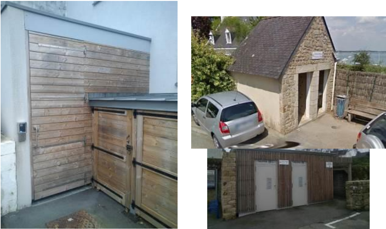
Figure 199 : Vues de blocs sanitaires sur le site des ZMEL.
