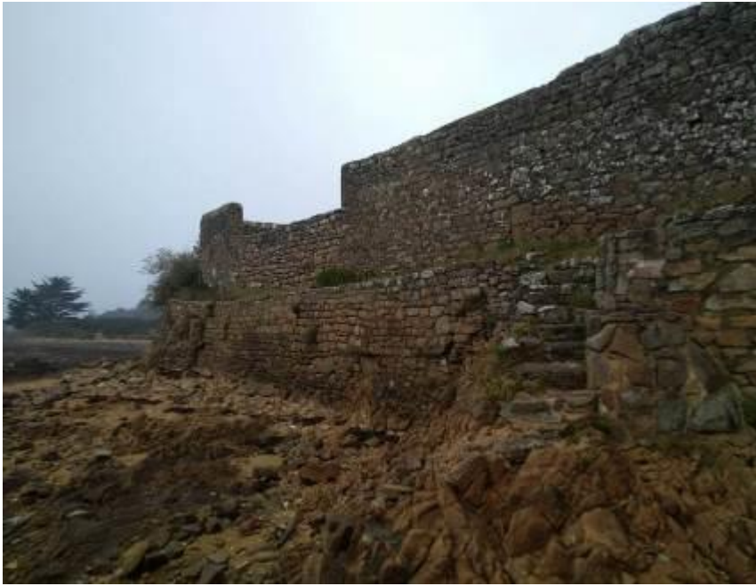
Figure 191 : Prises de vues d'accès privés donnant directement sur l'estran avec récifs en premier plan.
