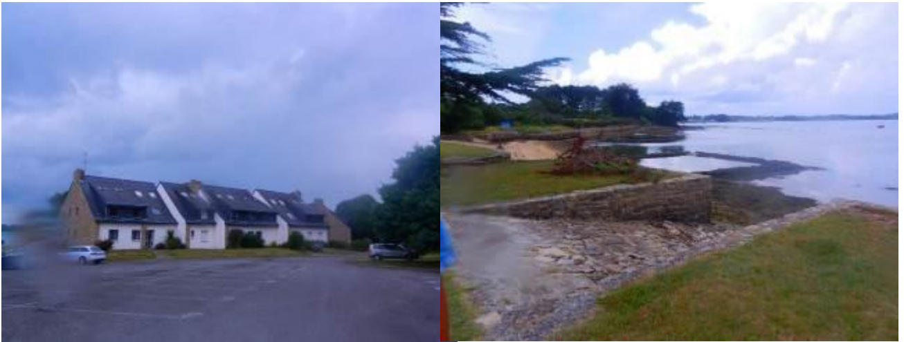
Figure 114 : Vue de la résidence (à gauche) et de sa rampe d'accès à l'estran (à droite).
