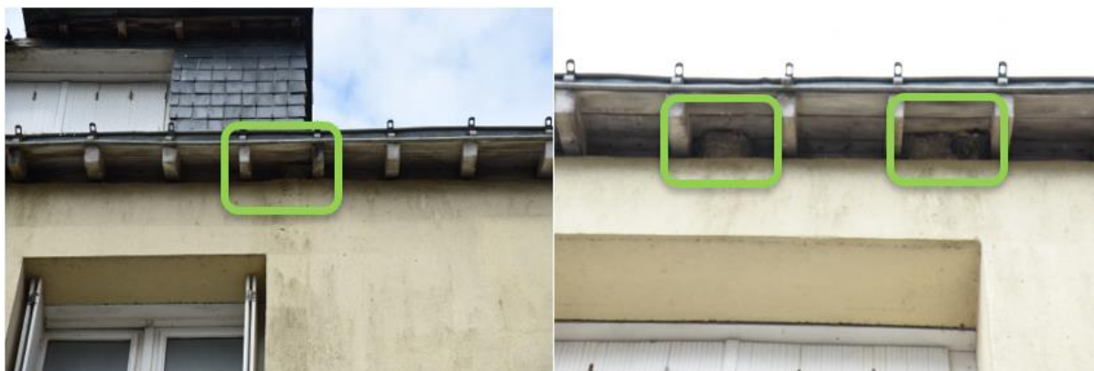
Figure 20. Vue de quatre des nids d'Hirondelle de fenêtre présents sur la façade rue Abbé Bihouée (façade est)
