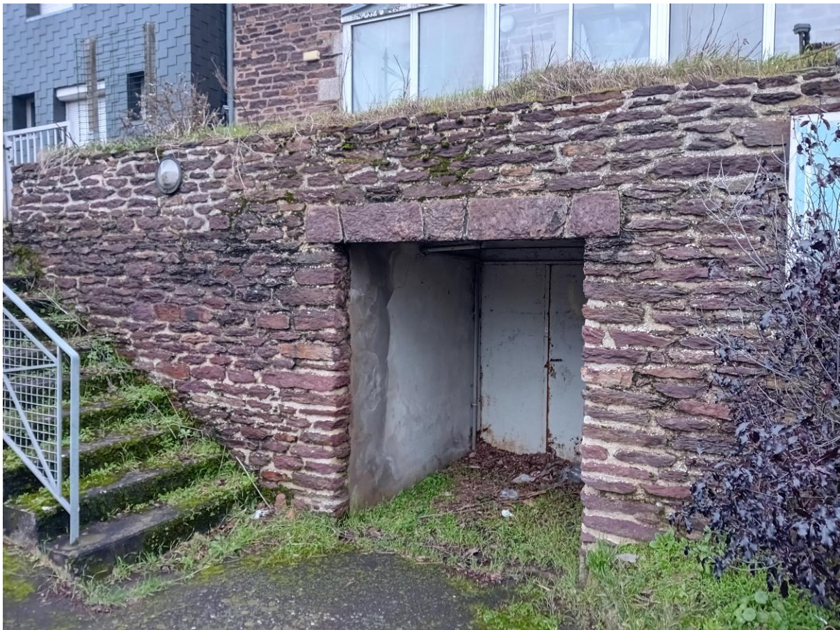
Figure 43. Porte donnant sur les sous-sols depuis la rue Paul Maulion côté sud
