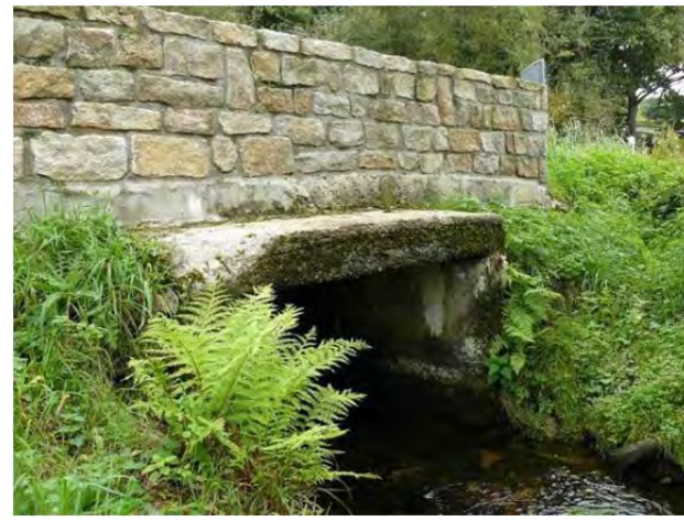
Photo 82. Cadre béton en aval de la RD162 (ruisseau le Saut du Renard)
