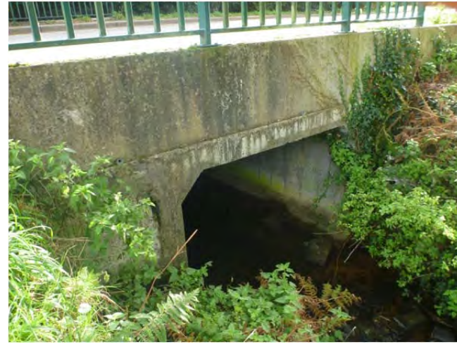
Photo 71. Ouvrage sous la voie communale. Tirant d'air plus important à plus forte perméabilité
