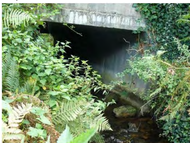
Photo 80. Cadre béton 1000x1500mm sous la VC2 au pont de Kerrouarch (ruisseau le Saut du Renard)
