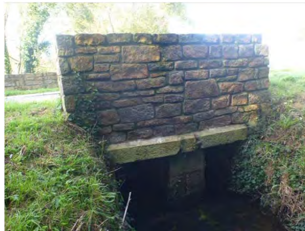
Photo 81. Ponceau en maçonnerie à proximité de la Vieille Saudraye (amont de la RD162)
