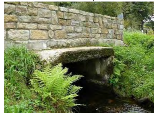
Photo 11. Cadre béton 1,75 m x 1,00 m sur le Saut du Renard côté aval de la RD162 (prolongement du ponceau en maçonnerie, photo précédente)
