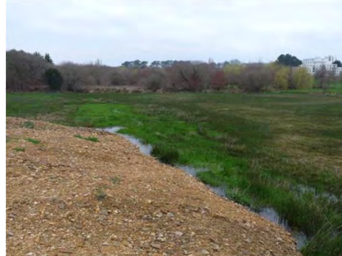
Photo 30. Remblai récent en zone humide
