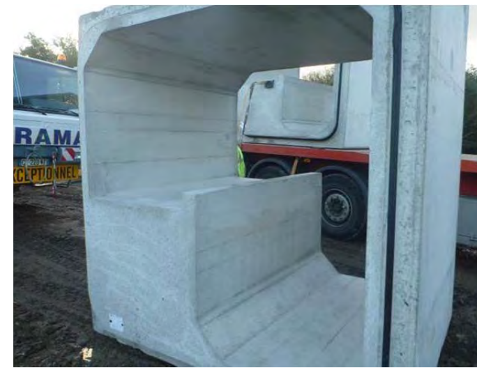
Photo 24. Elément du cadre 2,00 mx 2,00 m avec banquette petite faune
