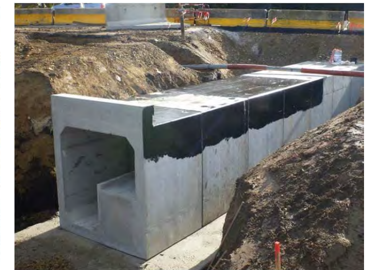
Photo 25. Pose du cadre béton sur le ruisseau de Billérit en octobre 2013
