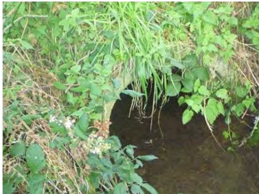
Photo 8. Buse béton Ø 500 mm côté aval du ruisseau du Gouéric
