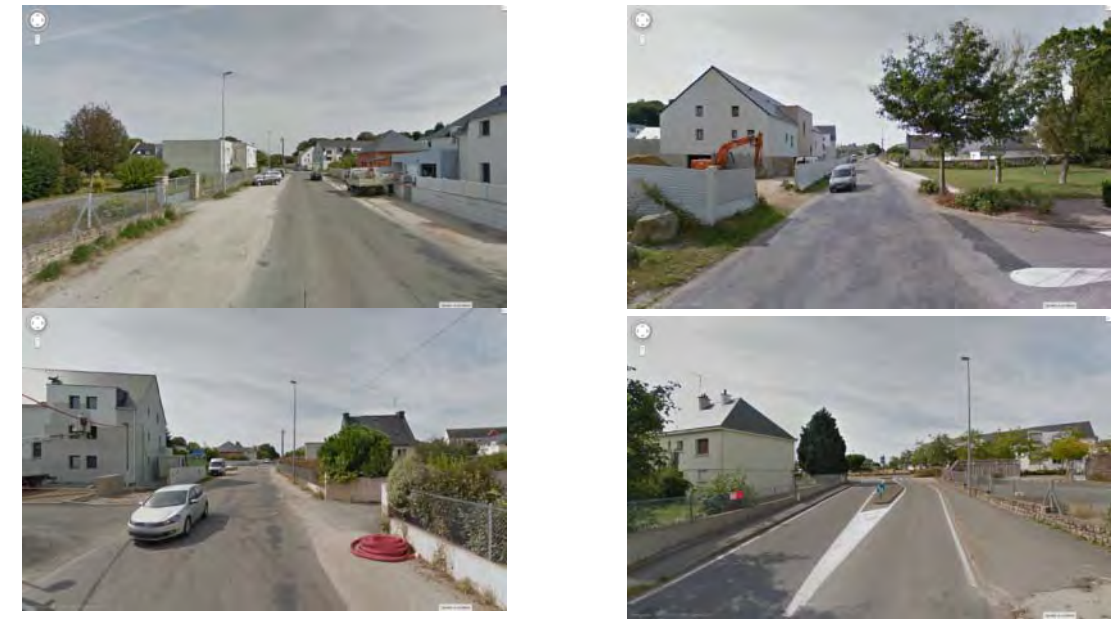
Vues de la Rue Général de Gaulle
