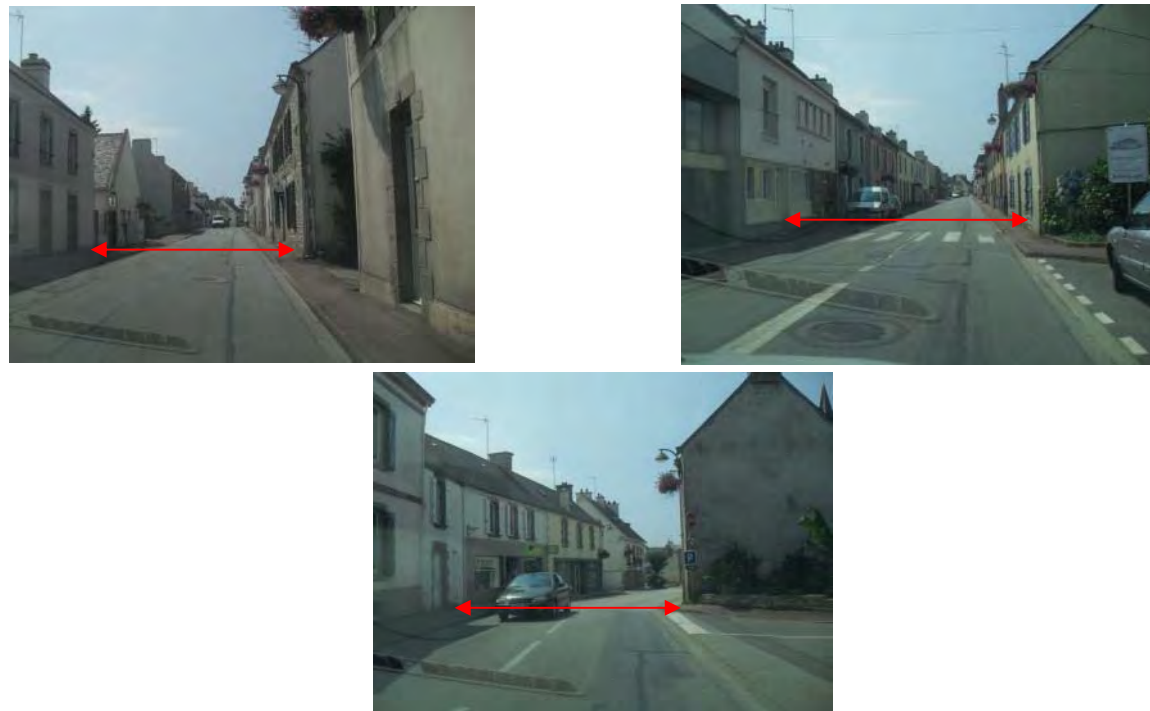
Photos : la largeur de la rue est de 9,30 mètres. Insuffisant
