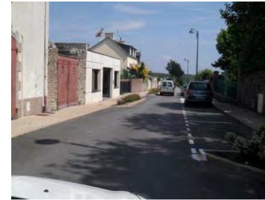
Photo : largeur moyenne est de 10,15 mètres. Insuffisant. Actuellement en sens unique.
