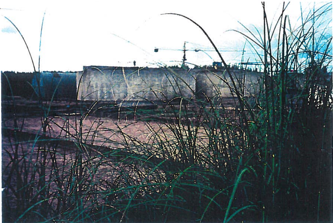
REDON : Station d'épuration sur la ZIP
