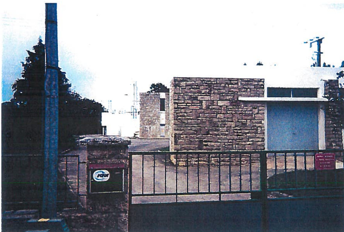
L'usine des eaux de Bellée (St-Congard) sur l'Oust
