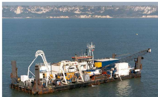
Barge aménagée pour l'installation de câble en secteur côtier
