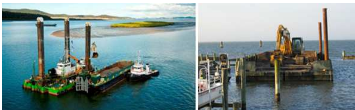
Figure 3 : Pelle rétro-caveuse (avec navire sablier et remorqueur) et Pelle mécanique sur barge (Source : RTE, 2016)
