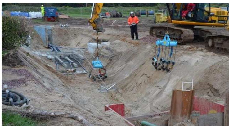
Figure 16 : Tirage du câble à l'atterrage (source : RTE, 2016)
