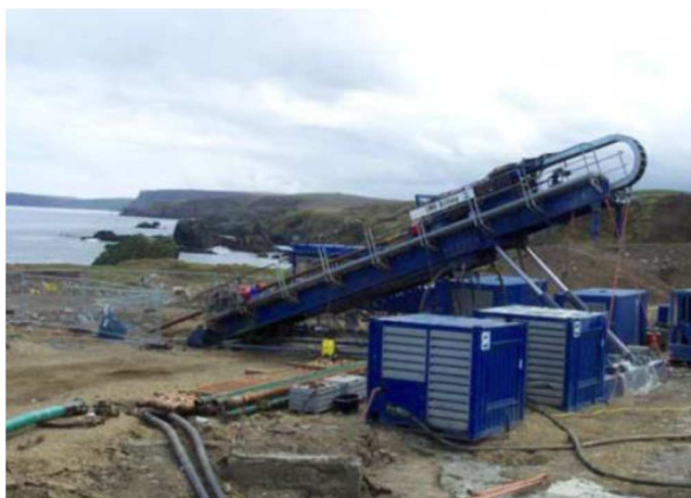
Figure 18 : Illustration d'une plateforme de forage (source : RTE, 2017)
