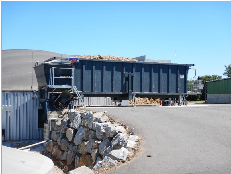
Photographie 13 : Exemple de trémie d'incorporation en extérieur (Source : ENCIS Environnement)
