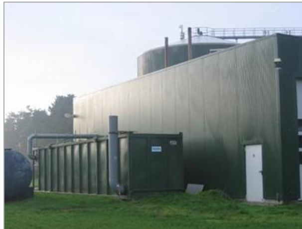
Photographie 18 : Exemple de biofiltre (Source : ENGIE BioZ)
