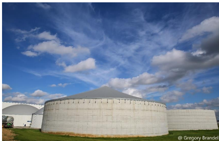
Photographie 15 : Exemple de cuve de stockage de digestat liquide (Source : ENGIE BiOZ)
