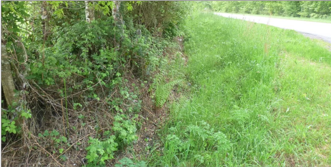
Photographie 10 : Fossé très profond longeant la D27 (Source : ENCIS Environnement)
