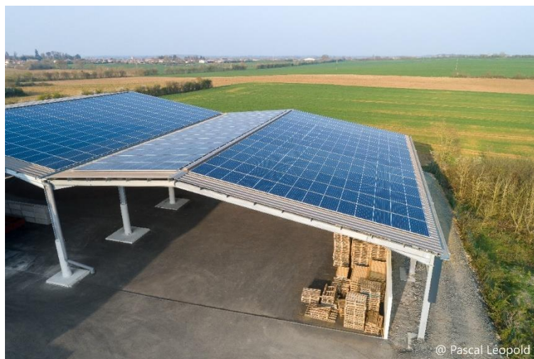
Photographie 16 : Exemple de toiture sur plateforme de stockage (Source : ENGIE BiOZ)
