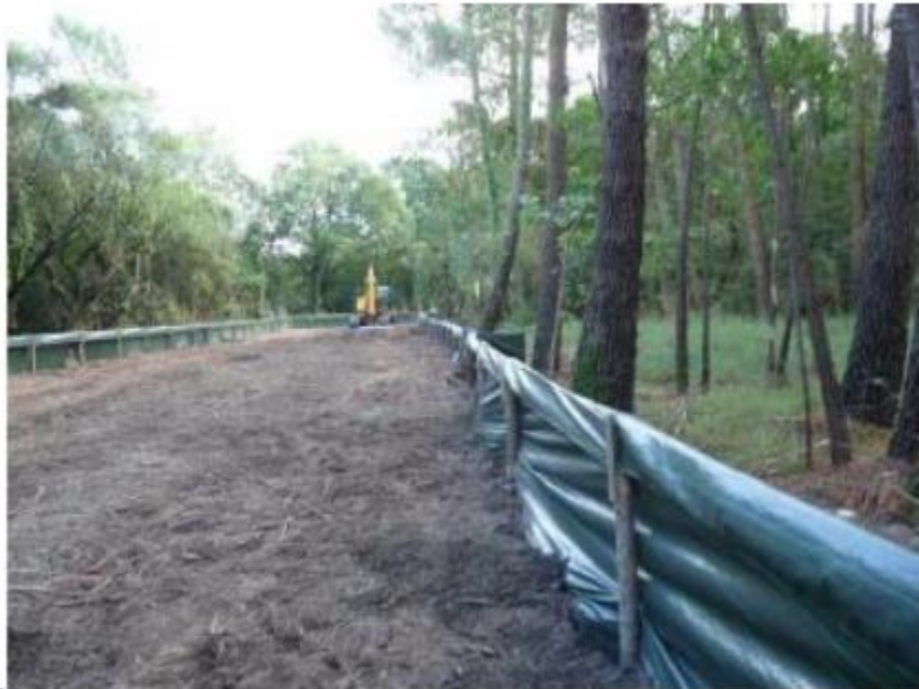
Figure 21 : Exemple de bâche posées pour éviter la traversée du chantier pour les amphibiens
