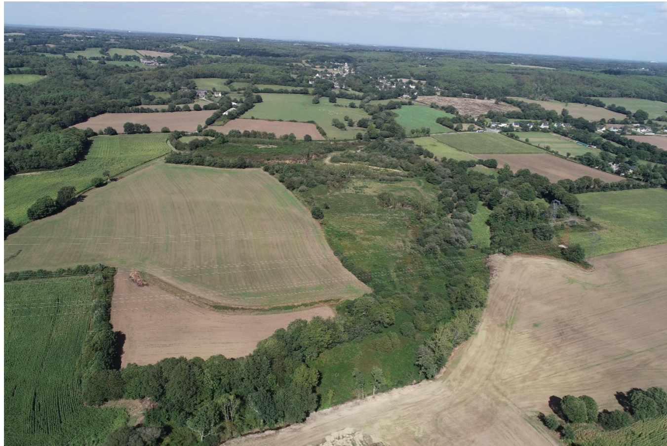
Figure 1 : Photographie du site
