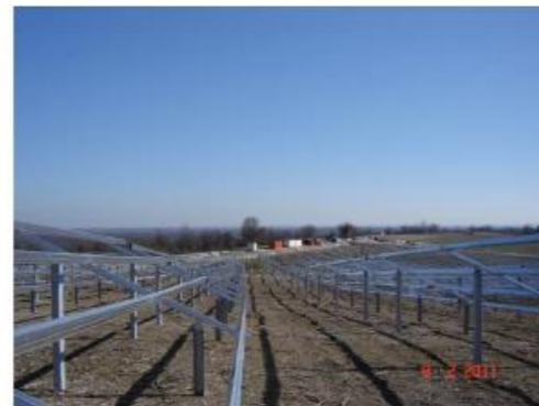
Fixation des rails de support
