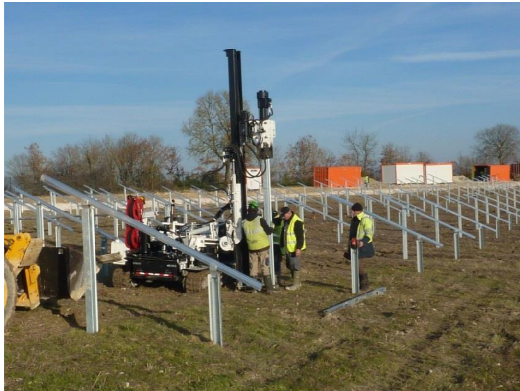
Figure 3 : Mise en place de support de panneaux
