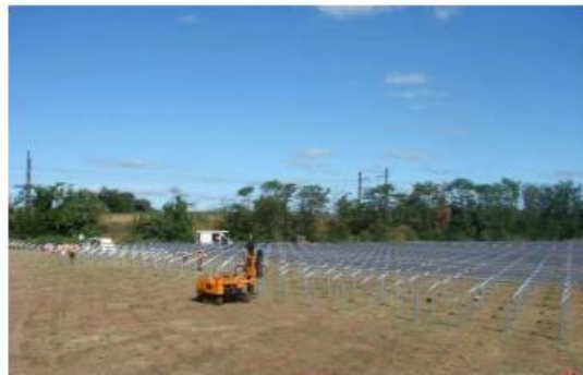
Battage des pieux
