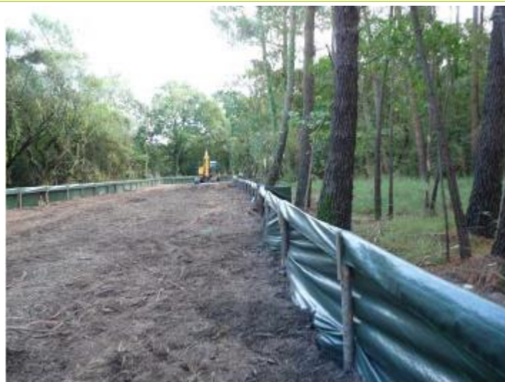
Photo 12 : Exemple de bâches posées pour éviter la traversée du chantier par les amphibiens
