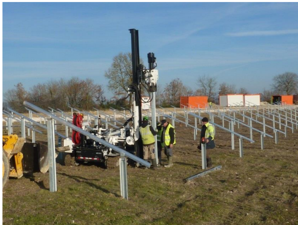
Photo 9 : Mise en place de support de panneaux
