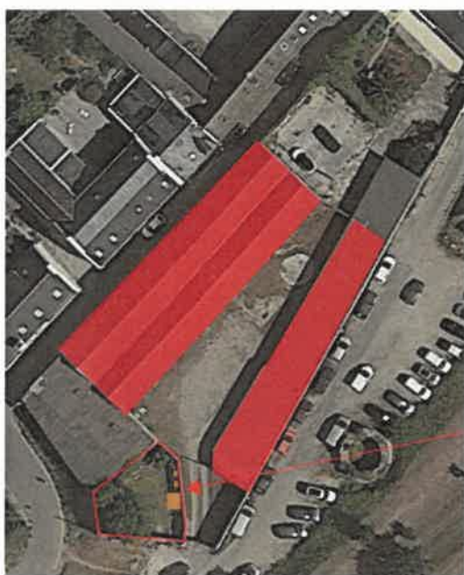
Vue aérienne. Etat existant
