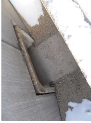
Figure 65- Exemple de batrachoduc (source : CEREMA)
