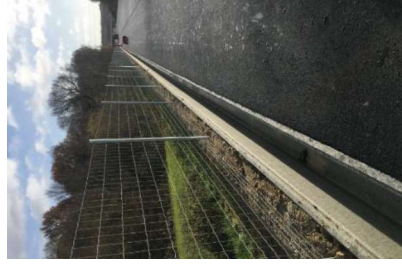
Figure 67- Exemples de clôture de type grillage possédant une hauteur de 1,5 m à 2 m et des mailles fines au moins sur les 50 premiers centimètres
