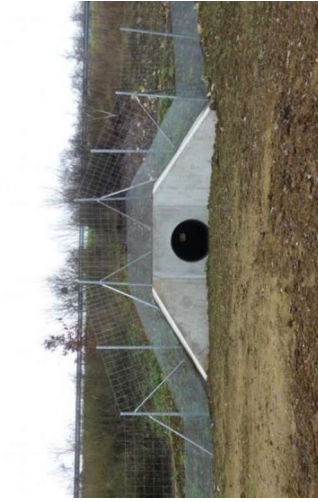
Figure 64- Exemple de passage inférieur (source : CEREMA)
