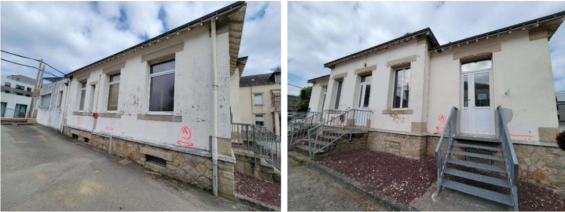
Figure 13. Vue du bâtiment CUISINE (© LPO, 2023)
