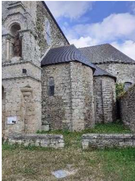
Absidiole centrale de la façade est de la chapelle Saint-Martin (© CHBA)
