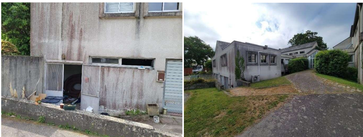
Figure 9. Secteur où niche les Hirondelles rustiques et aperçu du bâtiment (© LPO,2023)
