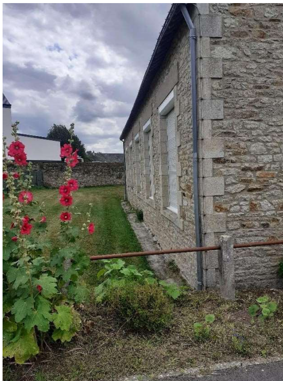
Façade est du local associatif (© CHBA)
