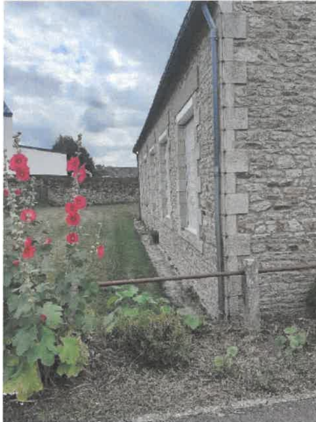
Façade est du local associatif (© CHBA)
