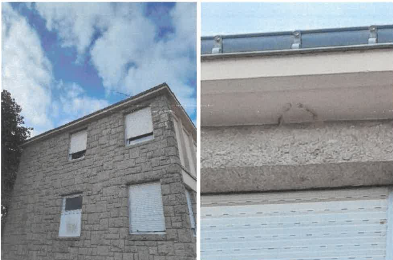
Avancée de toiture du bâtiment du lycée Ampère, et traces d'un ancien nid d'Hirondelle de fenêtre (© Biotope, 2023)
